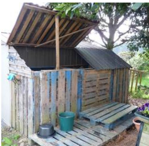
Une manière simple de réaliser ces bacs est d'utiliser des palettes comme armature, en remplissant les vides avec de la paille ou des brindilles ou tout autre matériau végétal local.
