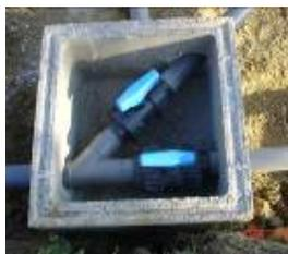
Dans une rehausse de regard (préfabriqué, non étanche), on installe un jeu de vannes (photo ci-contre).
