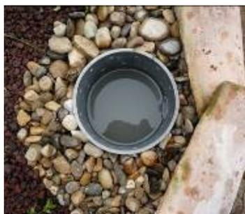
C'est un espace vide de substrat en sortie de bassin. Il est créé à partir d'une buse en béton ou en PVC, de 20 cm de diamètre et de 70 cm environ de longueur, posée verticalement. La buse est percée d'une trentaine de trous de diamètre 10 mm.
